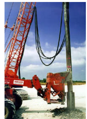
“Vibro Stone Column”
